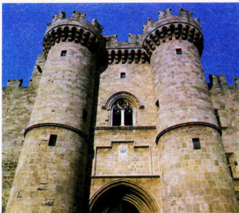
Φωτ. 9.3. Το παλάτι των Μεγάλων Μαγίστρων στη Ρόδο. Ισόδομο σύστημα δόμησης.
