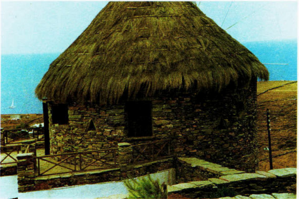
Φωτ. 9.11. Ανεμόμυλος στον Κούνδουρο της Τζίας. Οι οπιστόπλακες, που αφθονούν στην περιοχή προσφέρονται για δόμηση πλακολιθοδομής.
