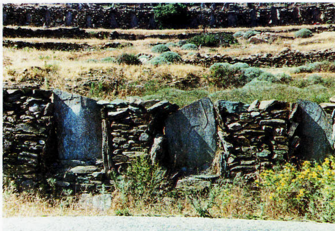
Φωτ. 9.12. Ξερολιθιά σε μαντρότοιχο στην Άνδρο.
