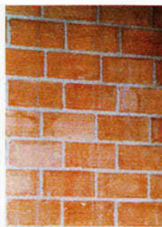
Φωτ. 10.6. Ορθοδρομικός τοίχος (όψη).
