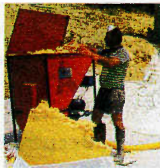
Φωτ. 10.19. Πλήρωση διακένων με μονωτικό υλικό σε κόκκους.
