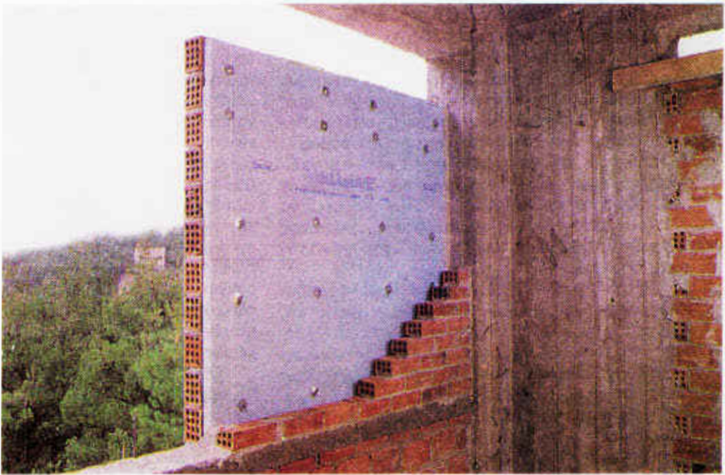
Φωτ. 10.12. Θερμομόνωση διπλού δρομικού εξωτερικού τοίχου με πλάκες εξηλασμένης πολυστερίνης.
