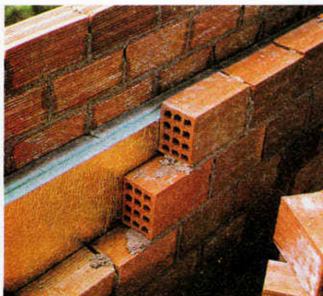
Φωτ. 10.15. Θερμομόνωση με σκληρό αφρό.
