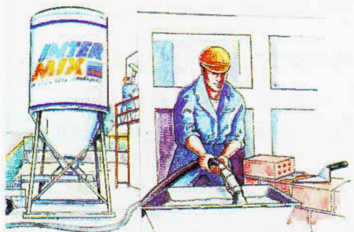
Σχ. 10.4. Δόμηση με έτοιμο κονίαμα.
