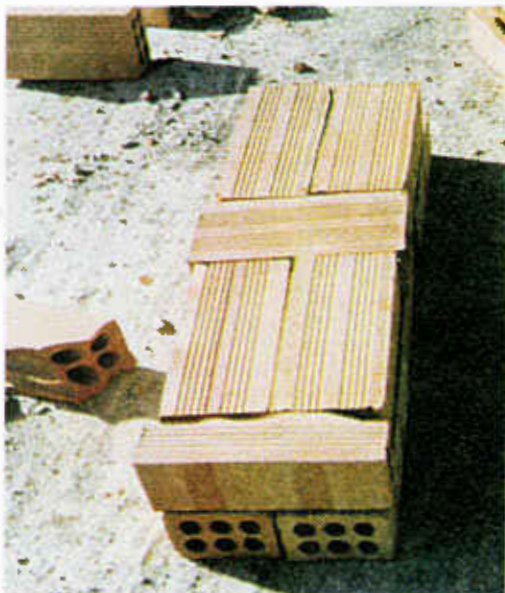
Φωτ. 10.21. Μπατικός τοίχος με απλή τοποθέτηση τούβλων.
