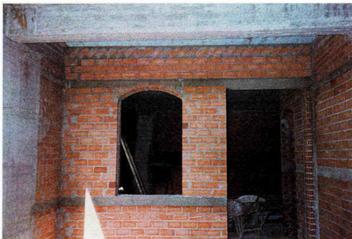
Φωτ. 10.9. Όψη τοίχου με σενάζ και ανοίγματα.
