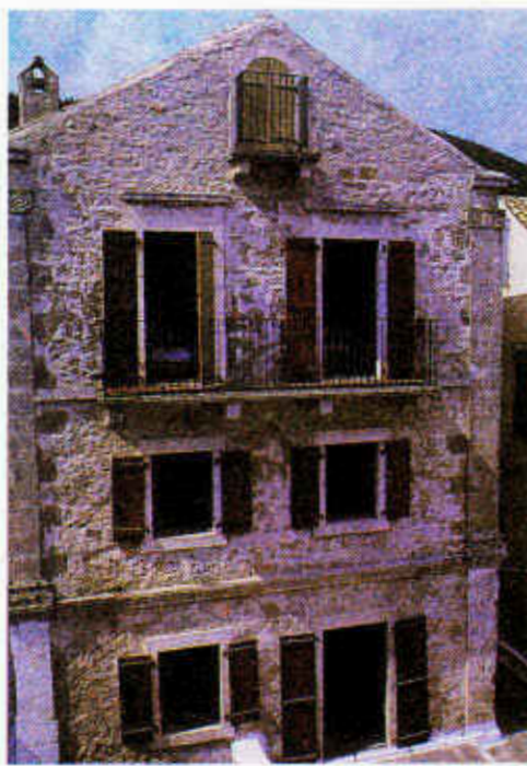
Φωτ. 11.8. Μετά την αποκατάσταση (1980).
