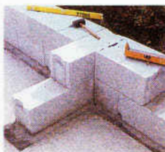
στ. Εγκάρσια σύνδεση.
