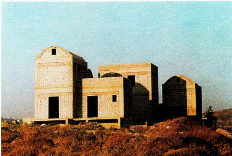
Φωτ. 10.25. Δόμηση με τσιμεντόλιθους σε κατοικία στη Σαντορίνη.
