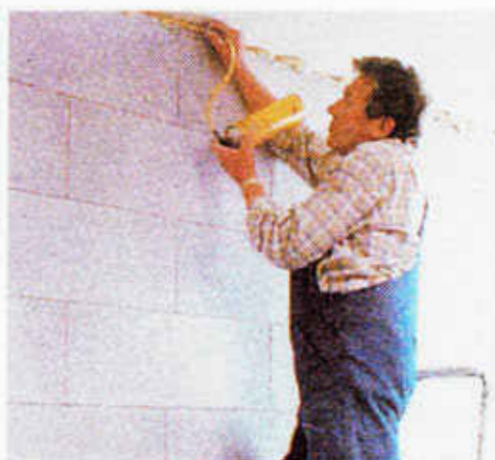
Φωτ. 10.27. Σφήνωμα με διογκωμένη πολυουρεθάνη.
