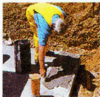
β. Κονίαμα και υγρομόνωση βάσης.
