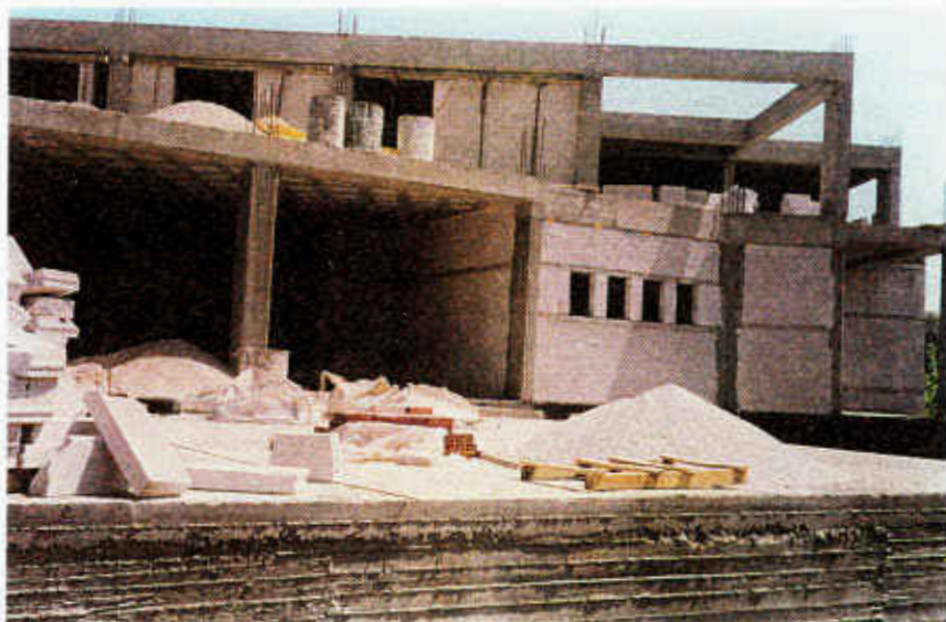
Φωτ. 10.26. Τοίχοι πλήρωσης με τεχνητούς λίθους από κυψελωτό κονίαμα.
