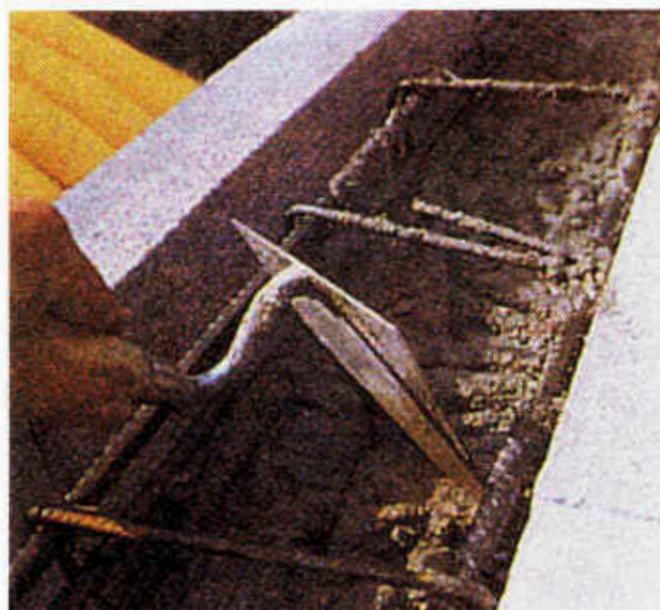
Φωτ. 10.29. Περιμετρικό σενάζ από οπλισμένο σκυρόδεμα.
