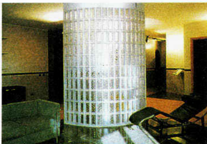
Φωτ. 10.31. Υαλότουβλα σε εσωτερικό χώρο.
