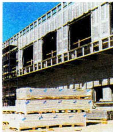
Φωτ. 12.3. Τσιμεντοσανίδες στο κτίριο του Κεντρικού Αεροσταθμού.
