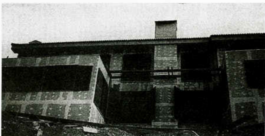
Φωτ. 12.4. Άνω: Σκελετός από οπλισμένο σκυρόδεμα. Κάτω: Συμπλήρωση με τοίχους από γυψοσανίδες.
