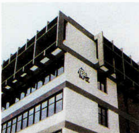
Φωτ. 12.2. Χυτοί τοίχοι και περσίδες από σκυρόδεμα.
