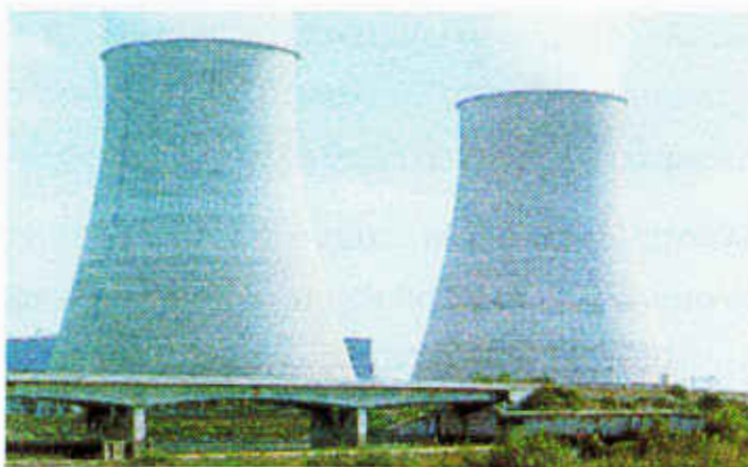
Φωτ. 13.10. Πύργοι ΔΕΗ από οπλισμένο σκυρόδεμα.
