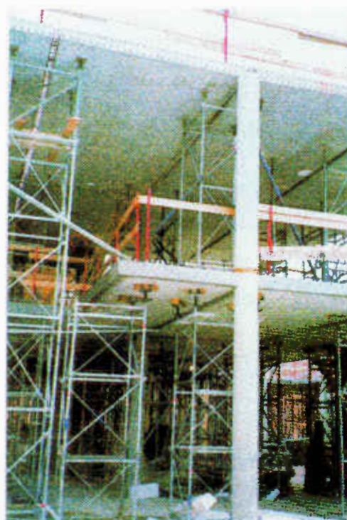
Φωτ. 13.11. Προκατασκευασμένη κατασκευή από οπλισμένο σκυρόδεμα.
