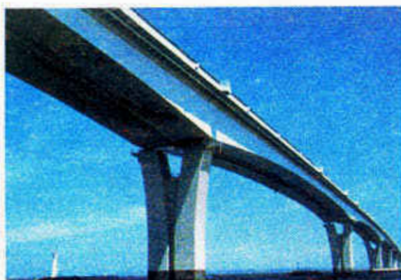
Φωτ. 13.8. Γέφυρα από οπλισμένο σκυρόδεμα.
