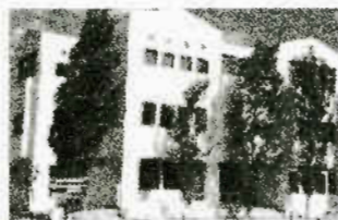
Φωτ. 13.2. Τριώροφη κατασκευή από οπλισμένο σκυρόδεμα.
