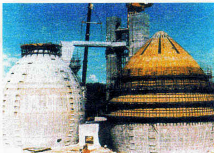
Φωτ. 13.7. Δεξαμενές από οπλισμένο σκυρόδεμα.
