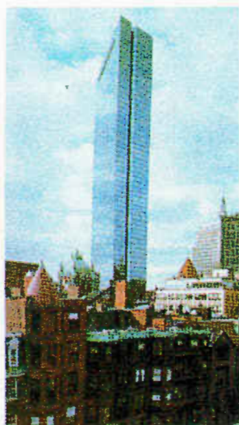
Φωτ. 13.4. Πύργος John Hancock στη Βοστώνη, ΗΠΑ.
